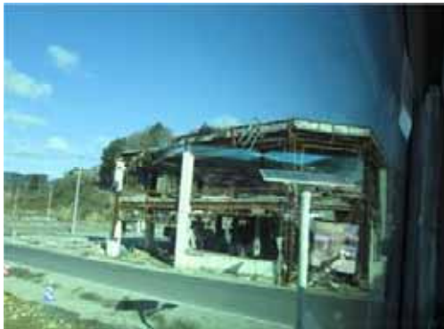
～女川町の被災状況～
