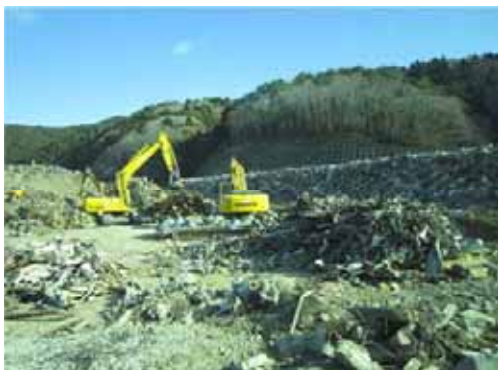
～一次仮置場での仕分作業～
