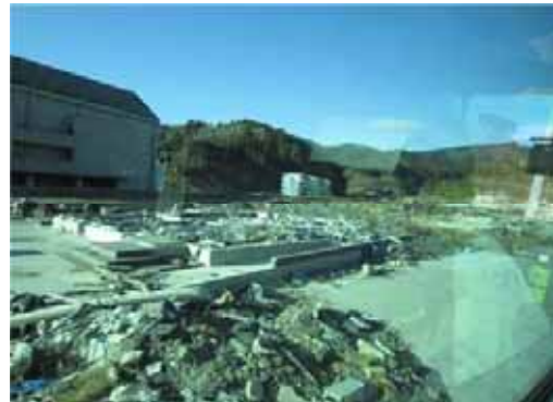
～女川町の被災状況～
