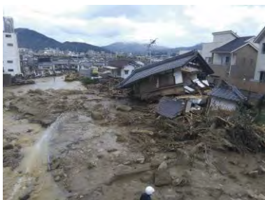
平成30年7月豪雨の被害の様子
