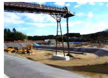
土壌貯蔵施設（双葉工区）
