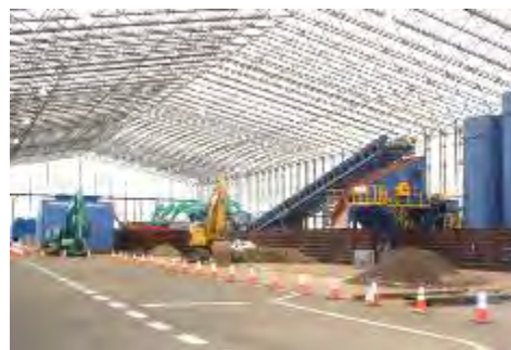
受入・分別施設（大熊工区）
