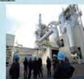
バイオマス発電所
