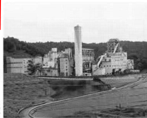
山城のようにそびえ立つ「東京たまエコセメント化施設」では焼却灰からセメントをつくる(5月19日、東京都日の出町)
