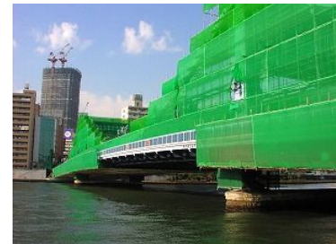
橋りょうの補修
