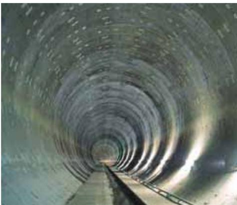
浸水被害が大きい神田川沿いに整備した内径8.5mの和田弥生幹線(全体貯留量15万w)
