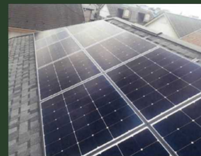
太陽光発電設置
